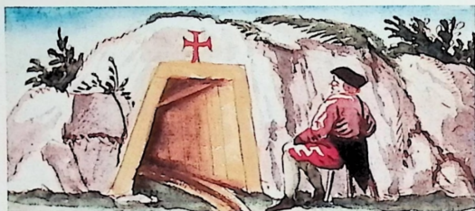
L'imbocco di una nuova miniera, con centine e "marciavanti" in legno.
