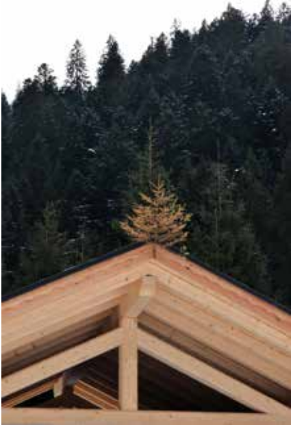
16. Un “pezòl” o “tasòl” inchiodato al convergere delle mantovane, al vertice della copertura di un fienile appena costruito. Canal San Bovo, località Refavaie 2017.
