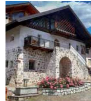
originali (tranne l'apertura del sottoscala). Particolare è la presenza del camino a sbalzo supportato da una struttura lignea e il graticcio di tamponamento del timpano.
